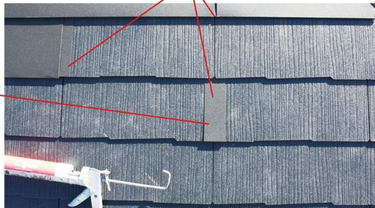
3：既存の平板スレートに下図の遵守事項を守って、弧を描くように専用接着剤を塗布していきます。
