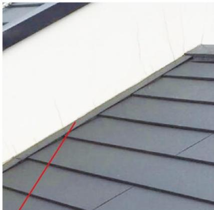
雨兼（雨押え兼用水切り）はこの箇所が15mmつばになっておりコロニアルは15mmつばに飲み込まれているので、シーガード本体は10mm程度つばの中に入るように納める。
