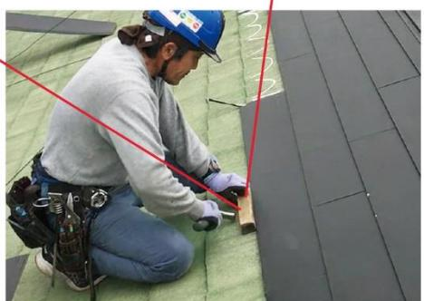
←③最後にシーガード左右勘合の隙間を調整するため、シーガード端部にバールを当ててハンマーでおします。
