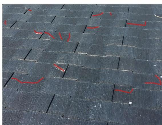
↑割れが目立つが、欠損条件が施工基準に満たされている。
