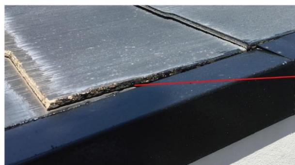
AケラバはBケラバと違いつばがなく、コロニアアルがケラバ板金に突きつけでおさまっています。シーガード本体を切りっぱなしで納めるとコロニアアルの小口が隠れないので、写真のように折下げ加工します。
