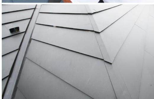
4:既存の平板スレートの施工で差棟の納まりが本体を両面の通りを合わせるために無理やり曲げておさえている施工も少なくはないので、そのような通りのズレを少しでもおかしく見えないように整えてください。
