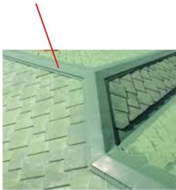
② 隅棟が差棟で隅棟際が隅板大で施工されていて、通常の本体のロングスリットと通りが合っている。
