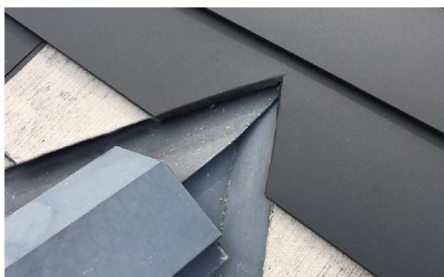
←ドーマー頂部は左の写真のように加工して施工してください。
