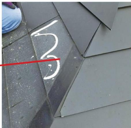
2:シーガード本体を隅棟芯に合わせて納めて、差棟が納まる個所の両サイドに、専用接着剤もしくは变成シリコーンを塗布します。
