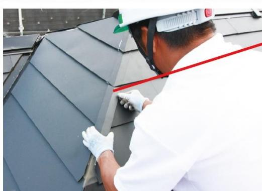
3:差棟上部が30mm以上、上の段の下に入り込むように差棟をはさみで加工し、
