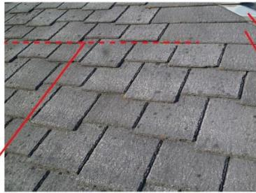
③ 隅棟が差棟で隅棟際が隅板大で施工されているのですが、通常の本体のロングスリットよりも 30 mm 程度下げて通りを出して納めている。
