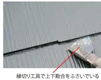
縁切り工具で上下勘合をふさいでいる塗膜を撤去する。
