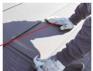
本体取り付け後、接着剤をしっかりと圧着させる意味で手で本体を押し付けて下さい。
