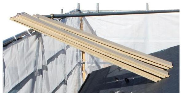
2：本体を割り付けて、ジョイントになる部分にウォーターチャンネルを差し込みます。
