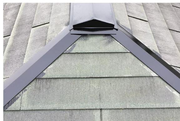
シーガード本体を隅棟役物に25mmの差し込んで納めるように寸法を測って、けがき、カットして差し込んでください。
