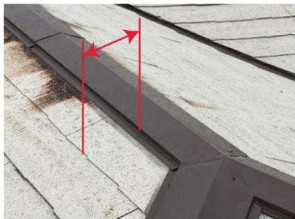
↑シーガードの棟際は上の写真のように棟際のコロニアル前端から棟板金の耳の付け根までの寸法で納めます。
