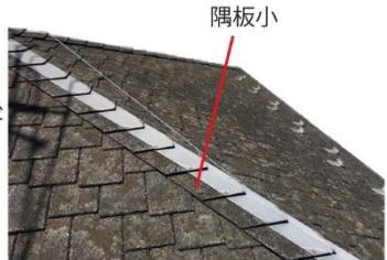
⑤ 隅棟が差棟で隅板大・小どちらも使わず施工し、左右の差棟の通りがバラバラで、本体も斜めに施工されている。\*まっすぐ施工されていてそろっている場合は大丈夫です。
