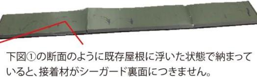
下図①の断面のように既存屋根に浮いた状態で納まっていると、接着材がシーガード裏面につきません。
