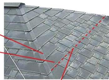
④ 隅棟が差棟で隅棟際が隅板小で施工されている。
